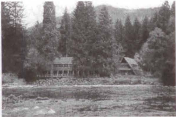
McKenzie Bridge, Oregon.
